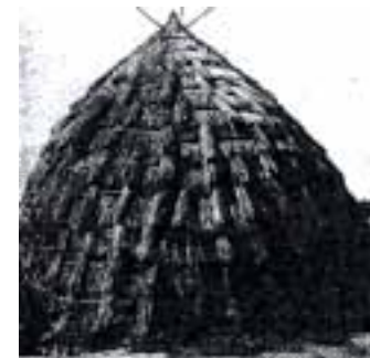
Κατασκευή Grass house.
