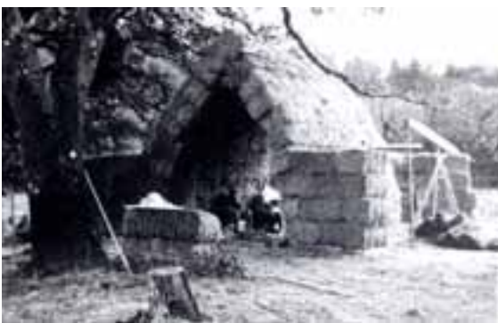
Αυτό το θολωτό περίπτερο από άχυρο χτίστηκε το 1996 ως Natural Colloquium Shenoa Retreat Center στη βόρεια Καλιφόρνια. Ήταν η πρώτη κατασκευή από δέμα με σύνθετη καμπυλότητα. [3]
