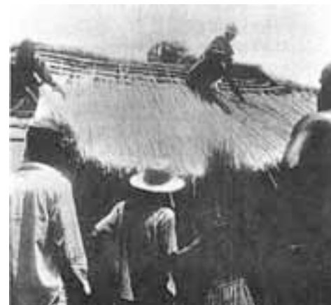
Κατασκευή ψάθινης σκεπής. [4]
