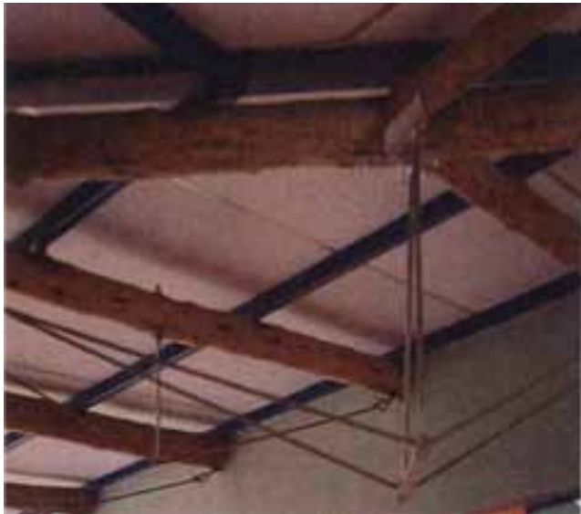
Λεπτομέρειες και συνδέσεις ξύλινων δοκαριών οροφής . [1]
