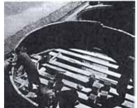
Κατασκευή τούβλινου θόλου πάνω σε τετράγωνη βάση. [4]
