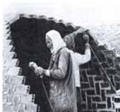
Κατασκευή θολωτών κατασκευών Ghorfa, Τυνησία. [4]
