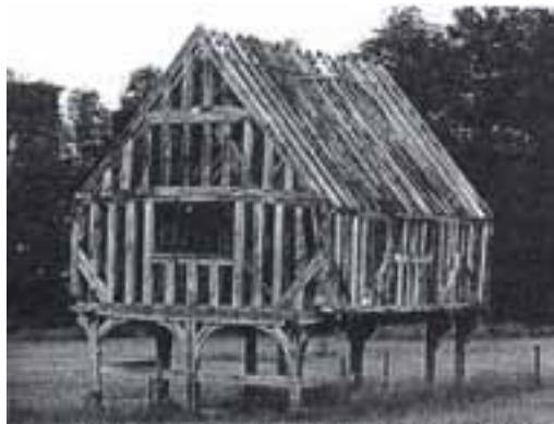
Δομικός σκελετός σε φάση αποκατάστασης στην Ουαλλία Sassex. [4]
